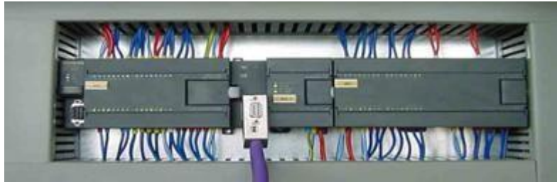
Resim 1.11: Bir PLC'nin pano içerisindeki bağlantıları
